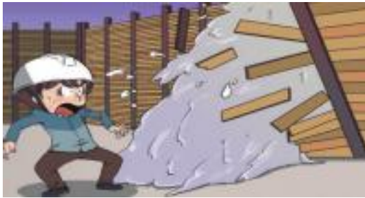
지반 연약화로 인한 흙막이 지보공 무너짐
